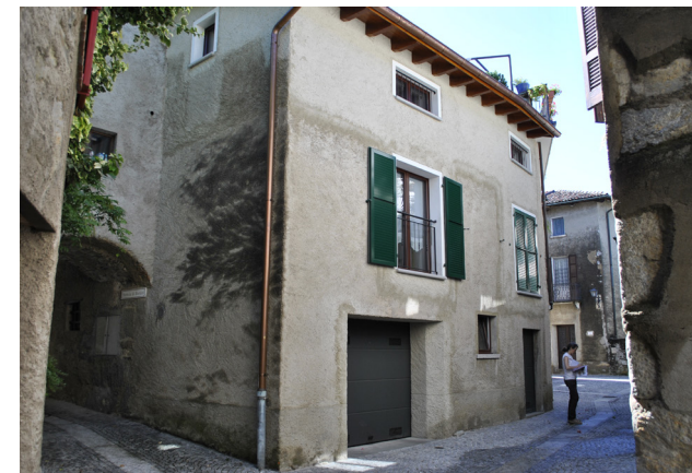
NB. foto da terra anno 2016, dopo interventi edilizi
