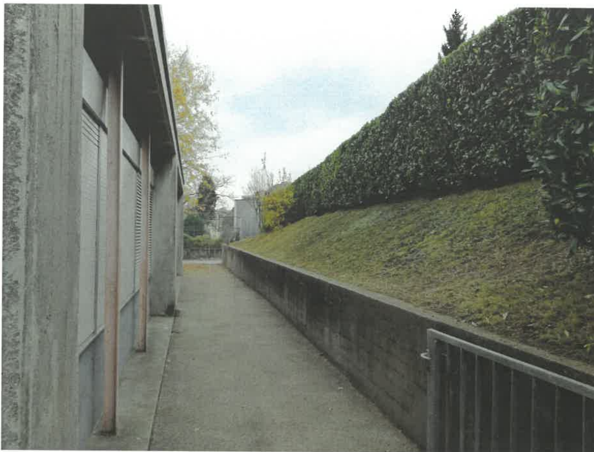
Lato esterno dove sono previste 4 aule scolastiche
