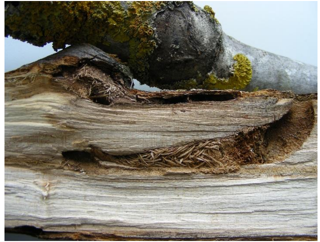
Albero danneggiato con le gallerie scavate dalle larve (Foto: WSL – Doris Hölling)
